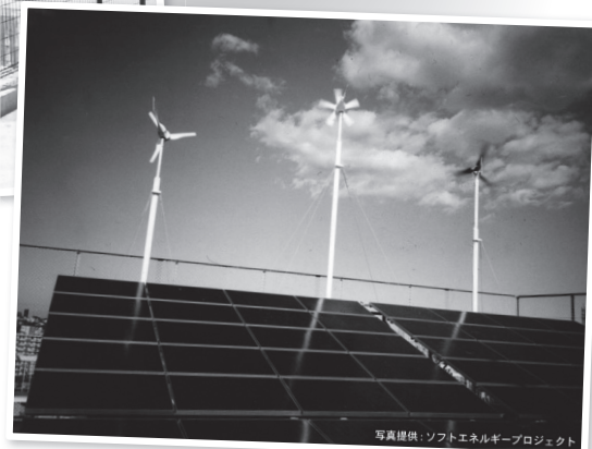
富士見学園市民共同発電所3号機。2001年設置。10KW太陽光発電と風力発電機3基(130W、300W、600W)を併設。(2001.12.22、ソフトエネルギープロジェクト)全国地球温暖化防止活動推進センターウェブサイトより ( http://www.jccca.org/ )
