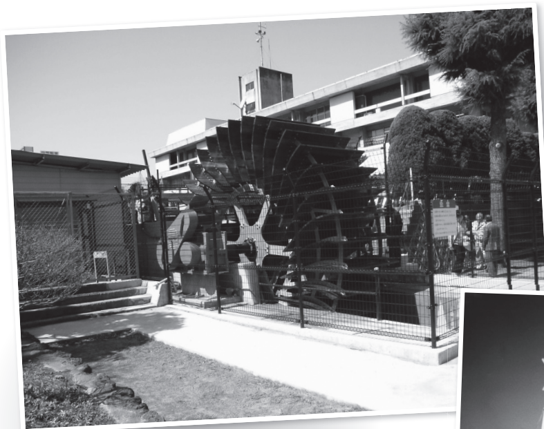
山梨県都留市が、市民からの出資（ミニ公募債）を募って建設した、都留市家中川小水力市民発電所「元気くん1号」。市役所駐車場に設置され、最大20kWの出力があり、市役所庁舎で消費している。 (全国小水力利用推進協議会 中島 大)
